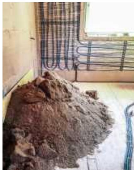
Im Hintergrund: Lehm- bauplatten (4 cm Stärke) bereits montiert. Im Vordergrund: loser Lehm (ca. 1 Tonne) steht bereit zum Verputzen.
