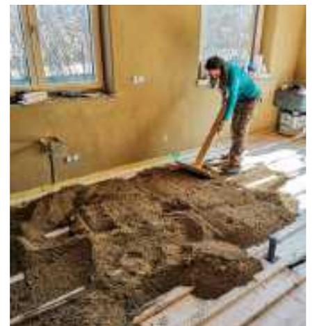
Stampflehm wird im Fußbodenaufbau eingebracht. Beide Fotos: Gerald Flöck
